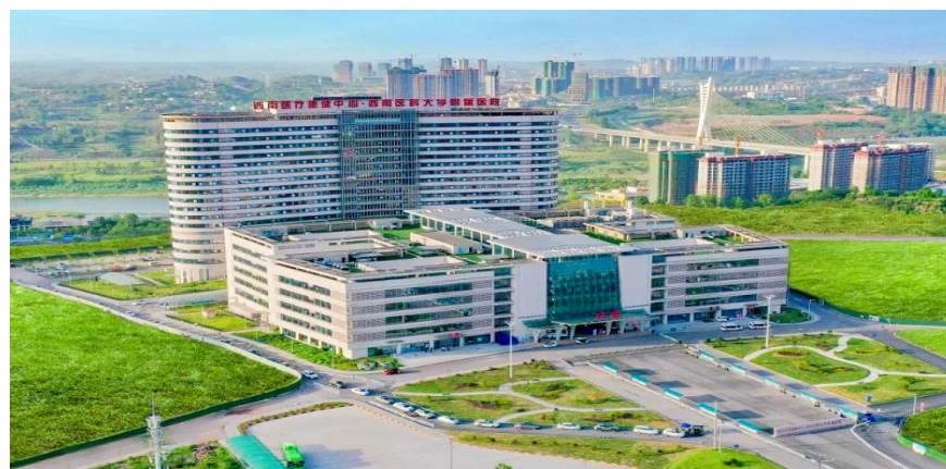
康健中心院区一期工程
